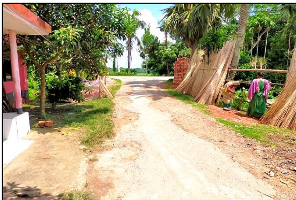
Road -06 Naria Pourashava
